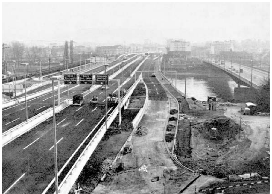
Die Schwarzwaldbrücke kurz vor Eröffnung Mitte der 70er Jahre. Jetzt muss sie saniert werden – mit einem Verkehrschaos in der Breite?
